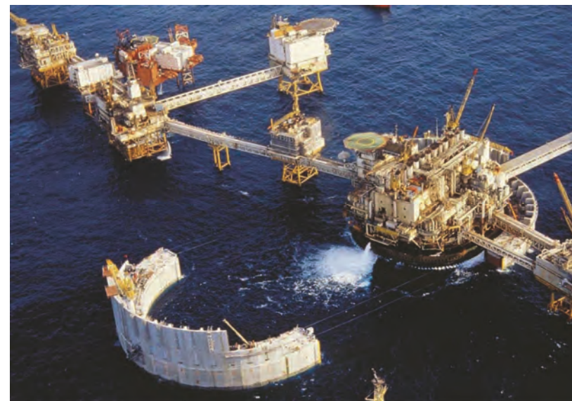
Рис. 3.18. Защита центрального нефтехранилища Ekofisk в 1988 г. [ConocoPhillips]
