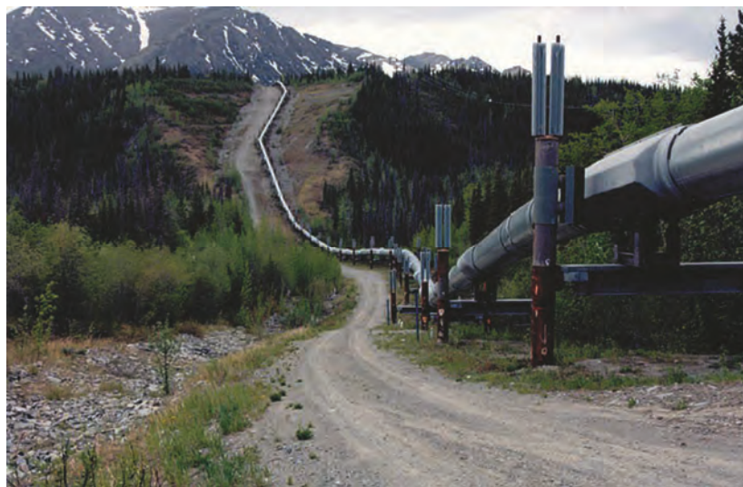
Рис. 2.13. Демпферная система нефтепровода TAPS на Аляске [Alyeska Pipeline Service Company]
